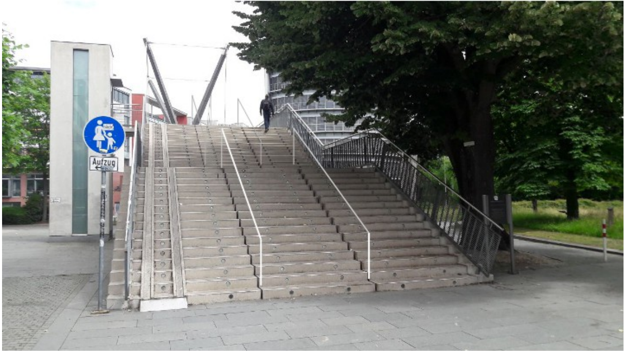
Nachrüstung von 2 Zwischenhandläufen an der Alfred-Herrhausen-Brücke
